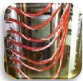
✓ 傳熱管道包覆保溫裝置，減少熱能消耗
